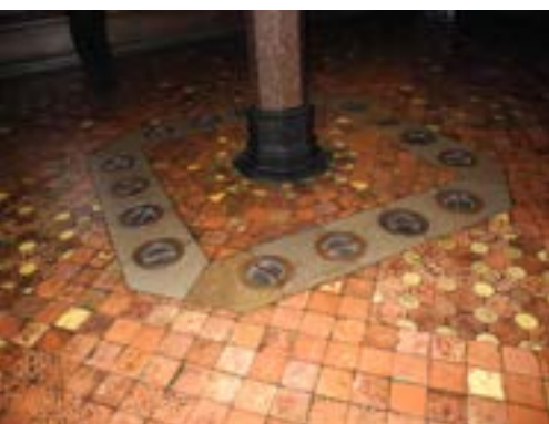
Malborkin linnan lämmitysjärjestelmän ilma-aukot. (kuva: Markku Rantama)
