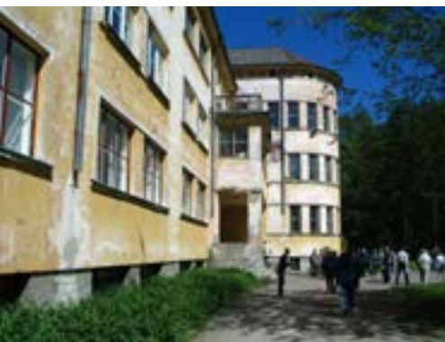
Pilottiprojekti 'Old School Building', Kotka-Järve, Viro (kuva: Markku Rantama)
